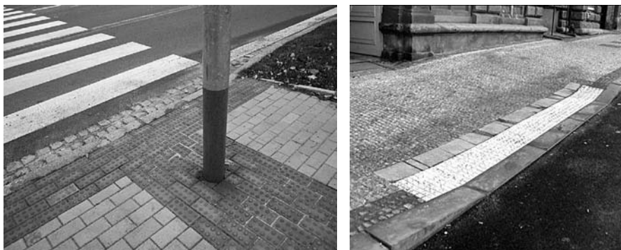
Obr. 46 Varovný pás vyznačující na přechodu (v místě sníženého obrubníku) hranici mezi vozovkou a chodníkem
