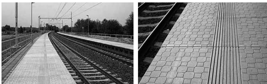
Obr. 49 Vodicí linie s funkcí varovného pásu
