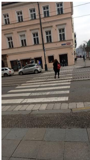
Foto 11 Nedostatky: Úpravy s varovným pásem na straně k ulici Na Florenci v mozaice bez funkčního lemování, protilehlá strana nedořešeny úpravy varovného pásu v hladké betonové dlažbě. Nefunkční a nebezpečné, nedostatečné nebo žádné úpravy!
