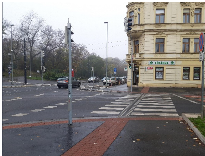
Obrázek 1: V okolí přechodu chybí hmatové úpravy, navíc na přechodu, vzhledem k jeho délce, má být vodící pás přechodu; nebezpečná, chybné.
