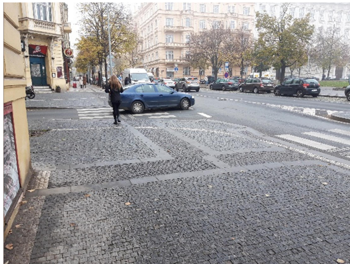
Obrázek 1: Správná certifikovaná dlažba signálního (SP) a varovného pásu (VP) včetně lemování; správné křížení dvou SP z hladké dlažby, správný vodící pás přechodu.
