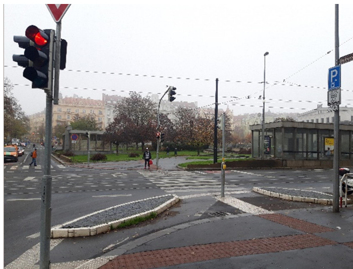
Obrázek 3: Dělený přechod se správnými hmatovými úpravami.
