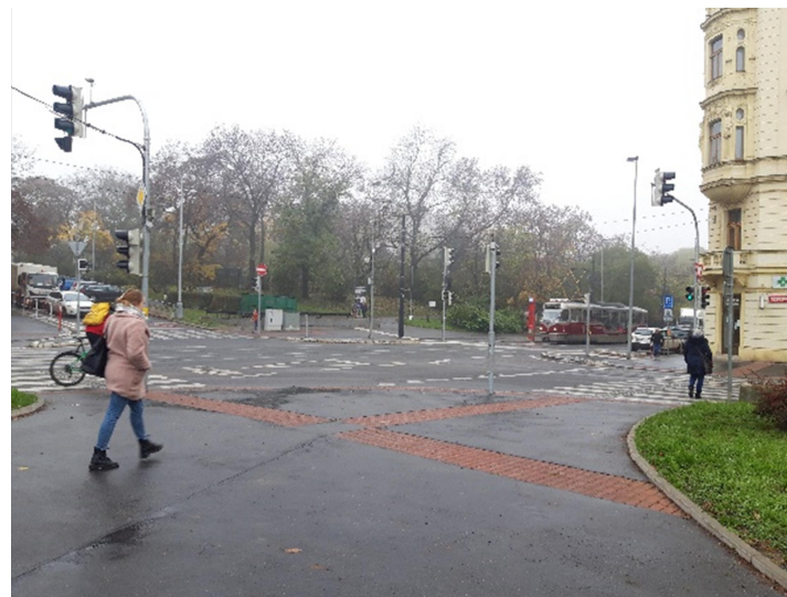
Obrázek 3: Správná certifikovaná dlažba signálního a varovného pásu (SP, VP) včetně lemování; správný vodící pás přechodu.
