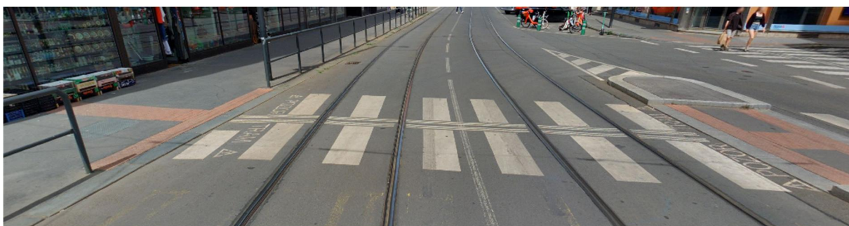
Foto 19. není odsazený varovný od signálního pásu u přechodu komunikace s tramvajovou tratí, správné řešení odsazení viz foto 8.
