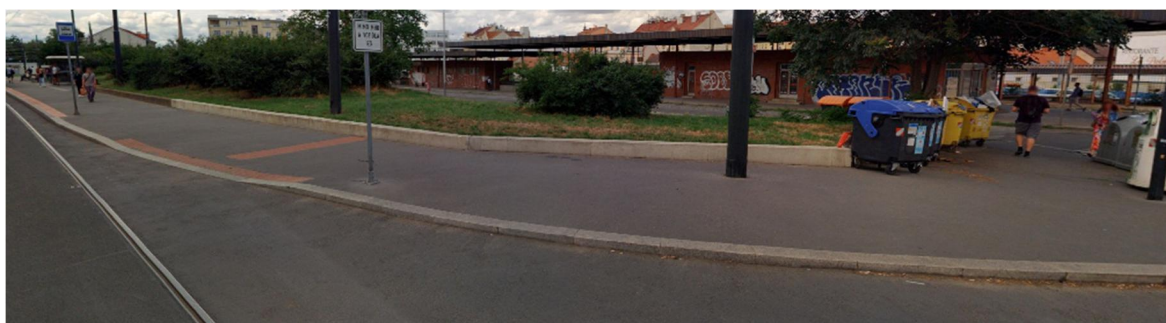
Foto 8. Správně provedené místo pro přecházení, podél přirozené vodící linie jsou umístěné kontejnery
