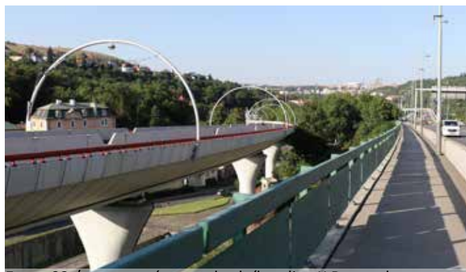
Etap 02 / opravy a úpravy chodníku ulice K Barrandovu a jižního pásu tramvajové estakády, včetně legalizace provozu
