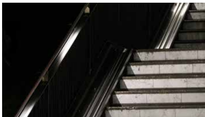
příklad osvětlení v zábradlí schodiště (NL / Nijmegen)
