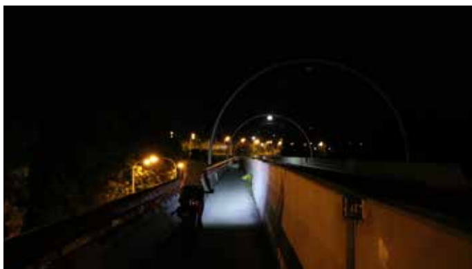
standardně svítí pouze každé druhé svítidlo nad TT, nicméně viditelnost je i s ohledem na jiná VO lepší než v extravilánu
