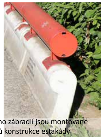
minimální potřebná výška zábradlí 1,30 m je pouze v blízkosti zastávky, kde je paradoxně převýšení nad terénem nejmenší
