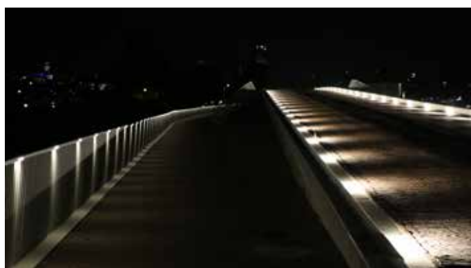
příklad osvětlení v zábradlí a svodidle (NL / Nijmegen) / v noci
