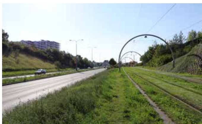
Etap 01 / stezka v úseku Geologická – předpolí estakád
