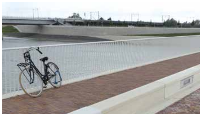
příklad osvětlení v zábradlí a svodidle (NL / Nijmegen) / ve dne
