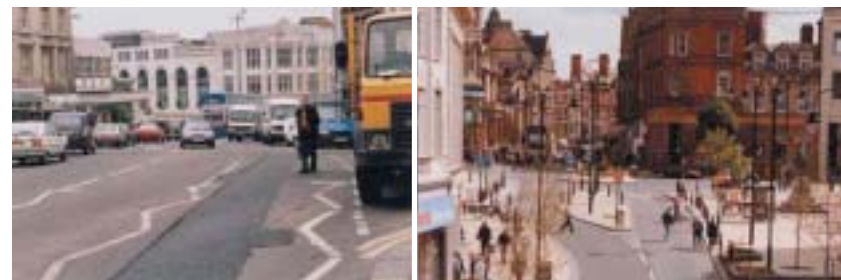
Queen's Square: před renovací (vlevo) a po ní (vpravo)
